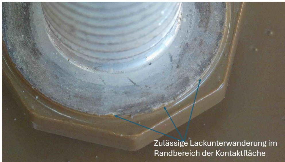
Abbildung 7-39: noch zulässige Lackreste auf Kontaktfläche
